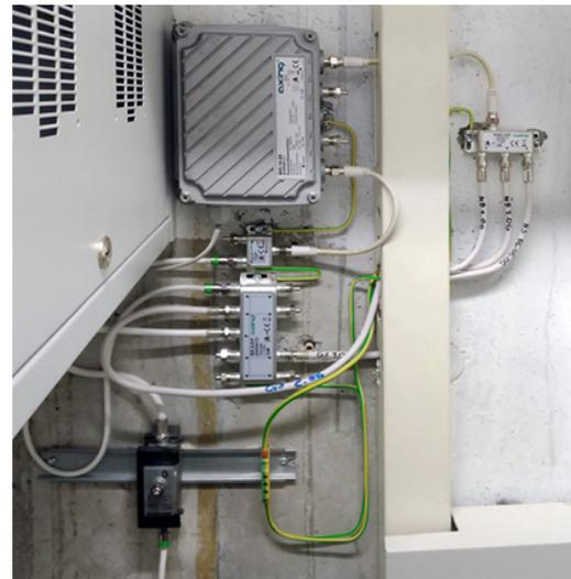
Links: AXING CMTS im Rack mit Patch Panel | Rechts: Die koaxialen Ausgänge des CMTS werden in das Rückkanal-taugliche Kabelnetz eingespeist
