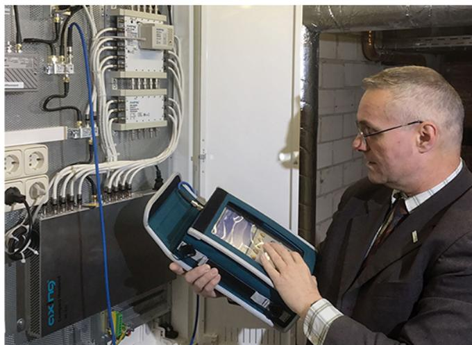
Bei der Inbetriebnahme unterstützt Herr Kuhfs nicht nur mit Rat und Tat, sondern auch mit einem Messgerät. Damit kann der Verstärker eingepegelt und ein Soll- / Ist-Vergleich der Kopfstellen-Signale vorgenommen werden. Jeder der 16 DVB-C Ausgangskanäle transportiert 5 bis 20 digitale TV-Programme.
